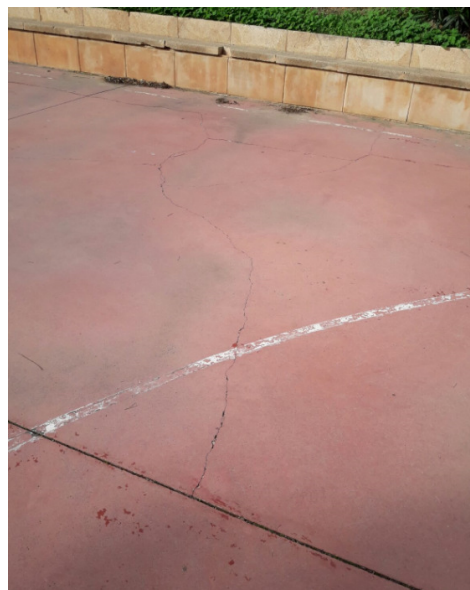
Imagen 3: Grietas en el pavimento
